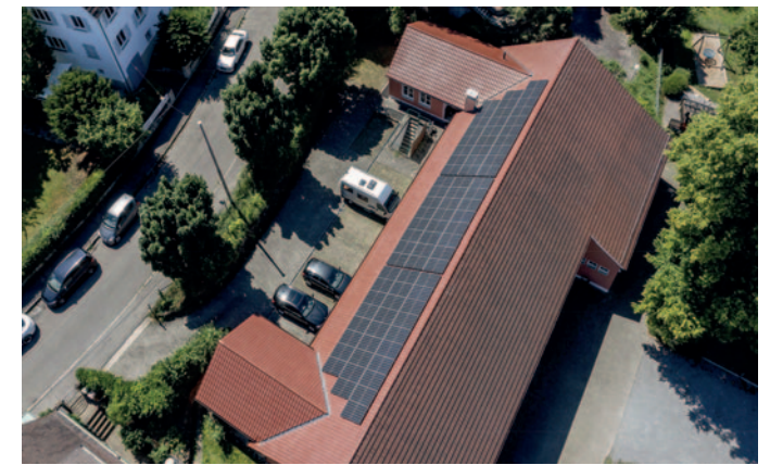
PV-Module von oben
